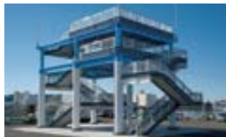
津波待避所を備えた 監視所 设有海啸躲避处的监控处
