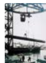
▲昭和初期、木材を陸揚げする テルファー（機械遺産） In early Showa era, telpher unloading timber (machine heritage)
